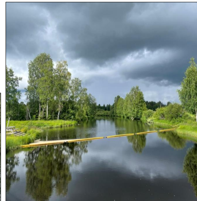
Exempel på avspärrning med säkerhetsbommar uppströms vattenkraftanläggningen Mjövattsforsen i Bureälven, Skellefteå kommun.
