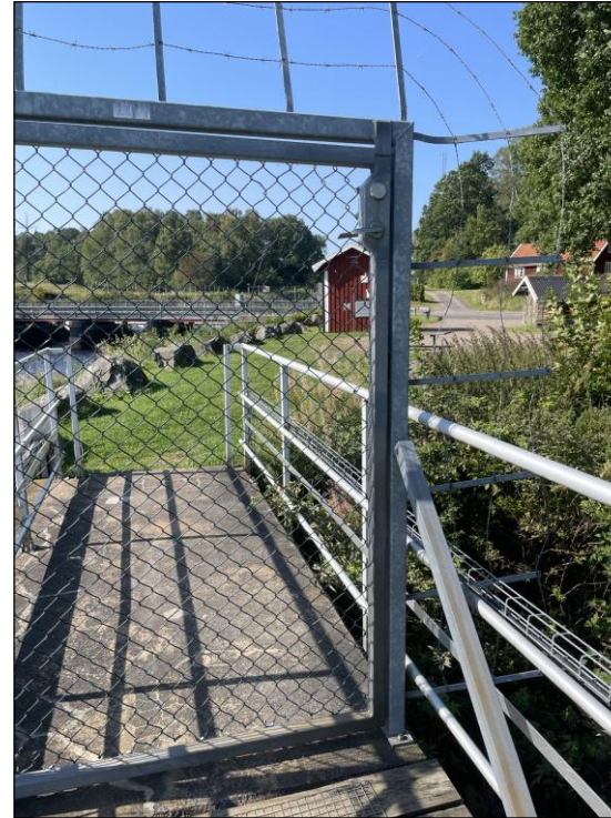
En vattenkraftanläggning där dammkrönet är försett med en grind, där handtaget för att öppna grinden har flyttats så att det är utom räckhåll för små barn
