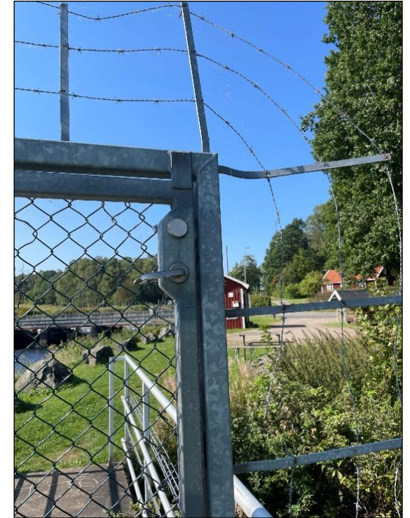
En vattenkraftanläggning där dammkrönet är försett med en grind, där handtaget för att öppna grinden har flyttats så att det är utom räckhåll för små barn
