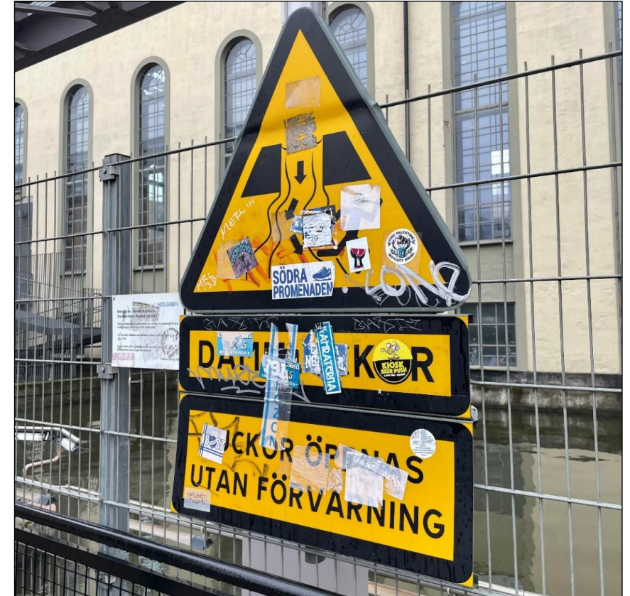
Exempel på en varningsskylt som är i dåligt skick och bör bytas ut.
